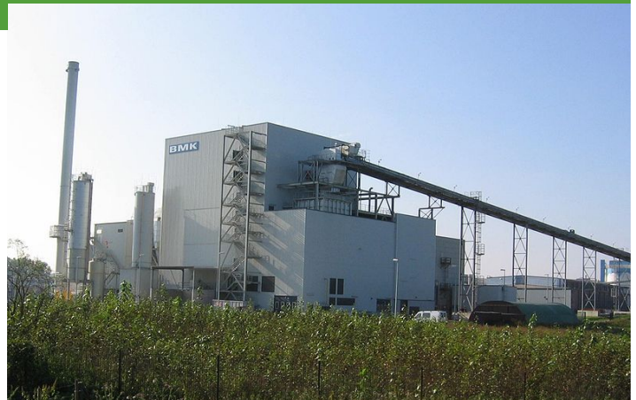
Das Biomassekraftwerk Lünen verbrennt 135.000 t Holz pro Jahr © R. Sielker
